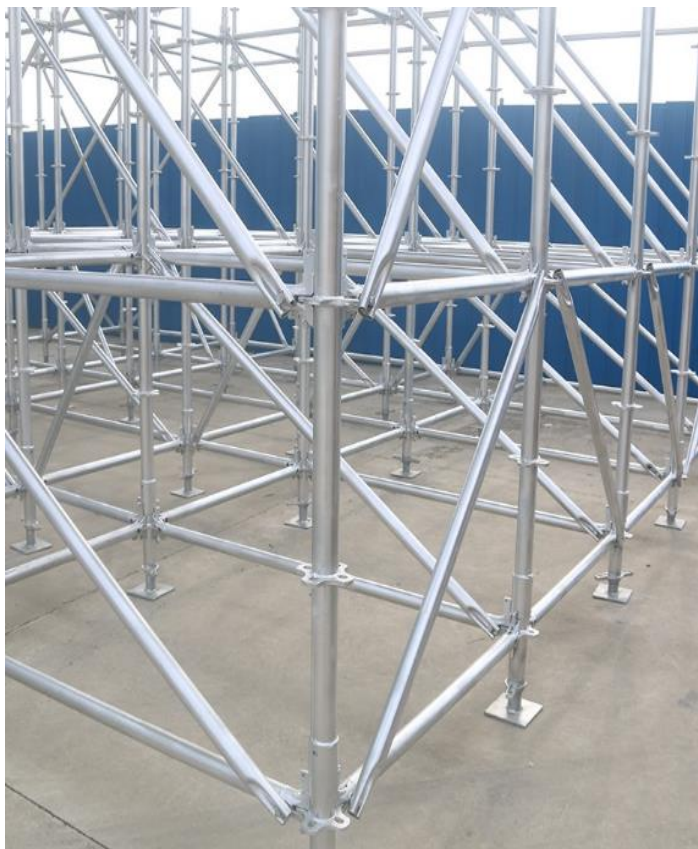
Рисунок 8. Визуализация инвентарных металлических оцинкованных строительных лесов.
